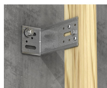
Fixação das traves de madeira
