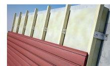
Instalação eventual de um protetor de chuva
