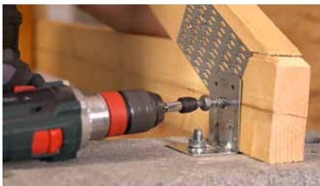
Por exemplo, a instalação de 20 suportes com o parafuso SSH demora 13 minutos contra 20 minutos utilizando o tradicional pregador numa mesma fila.
