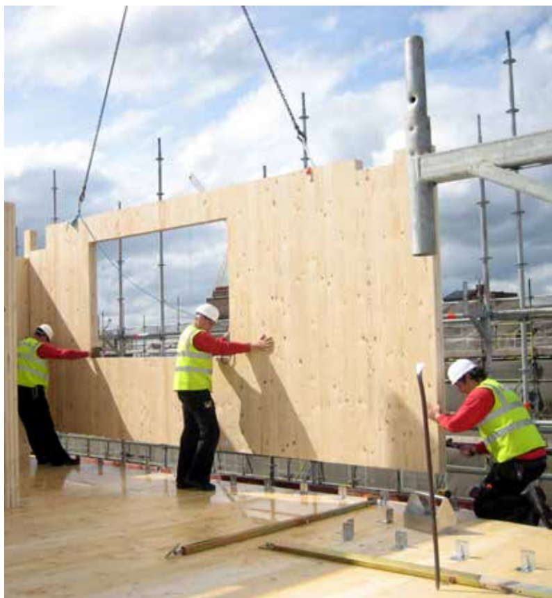
Stadthaus, Murray Grove. Imagem fornecida por KLH UK.
