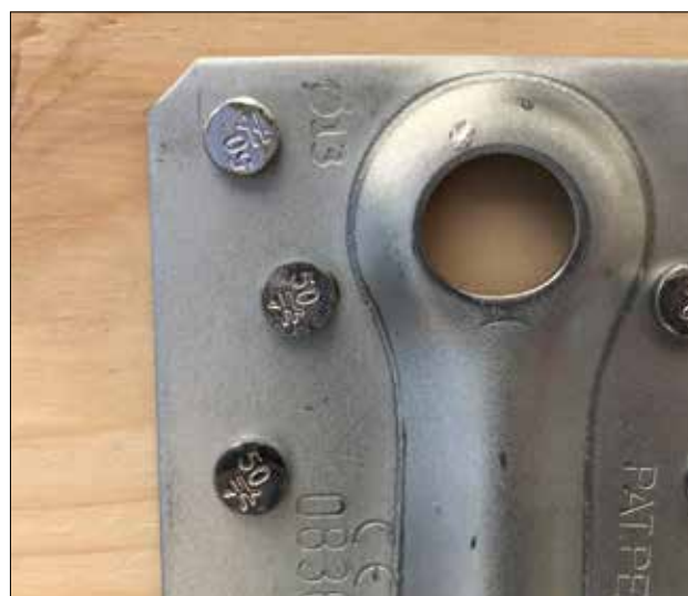
A marcação na conexão, além da marcação na cabeça dos pregos, facilita a verificação após a instalação
