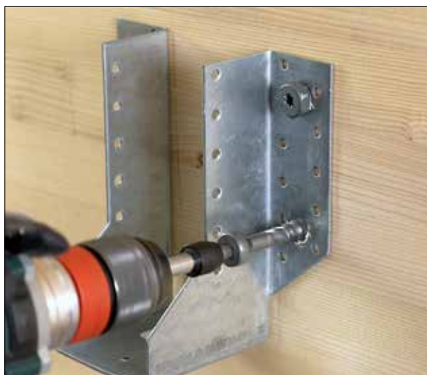
Suporte SAE instalado com SSH
