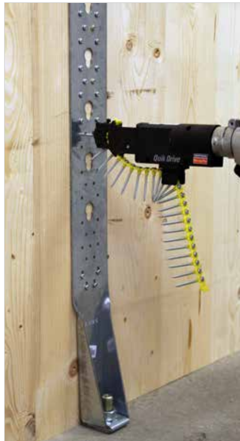
Ancoragem HTT31 fixa com parafusos em fita CSA para uma conexão parede CLT sobre laje de betão
