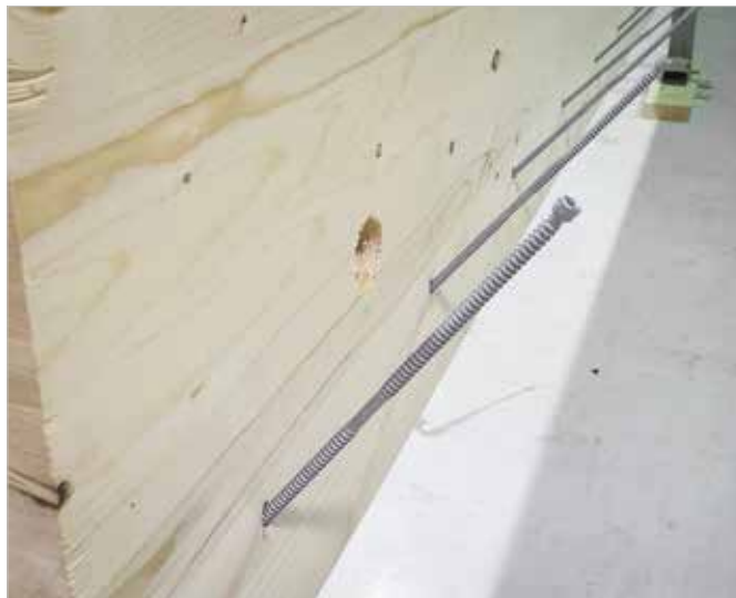
Parafusos SWD utilizados para uma ligação parede CLT sobre plataforma CLT
