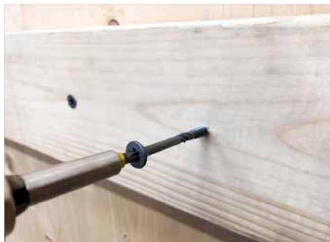
Acessório fixo com parafusos TTZNFS
